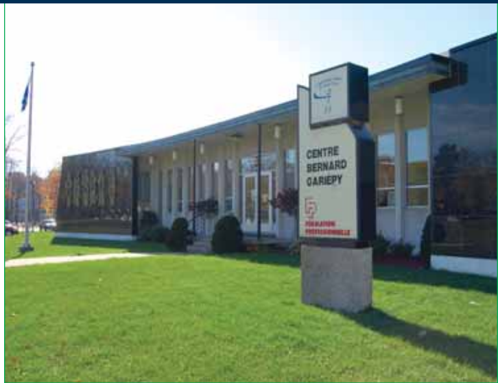
Le Centre Bernard-Gariépy de la Commission scolaire de Sorel-Tracy
