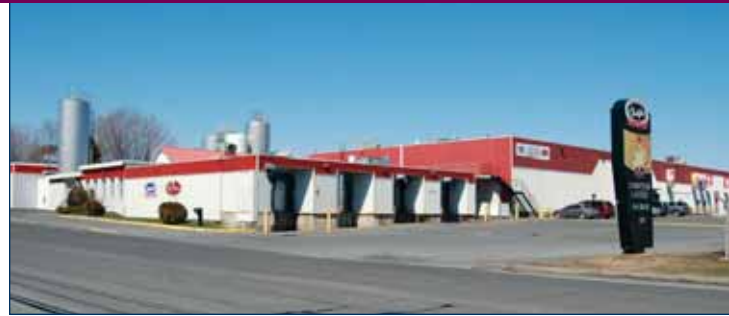
Les installations de la Laiterie Chalifoux
