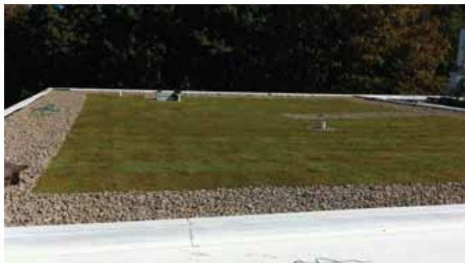
Toit vert surplombant le bloc D du collège
