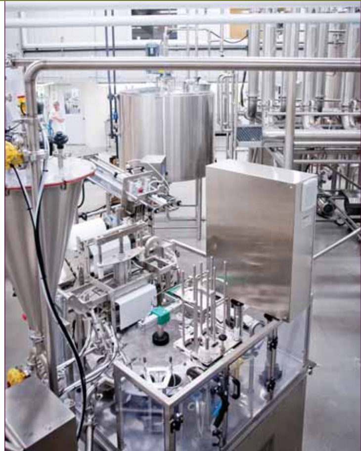
Les installations actuelles
