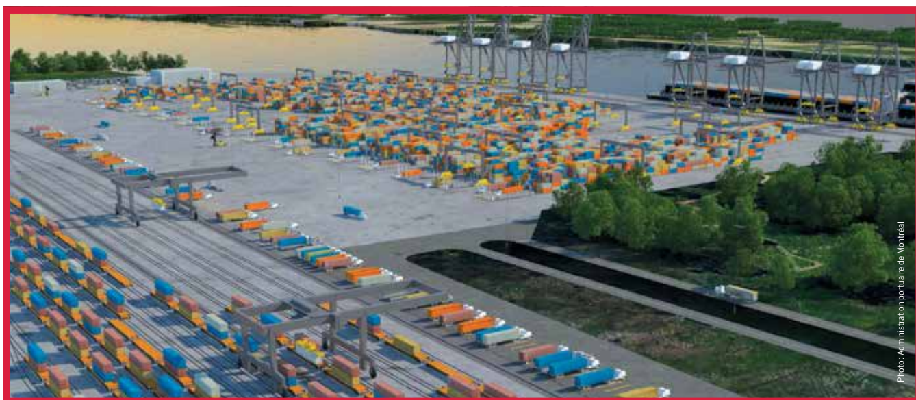
LE TERMINAL PERMET L'AMÉNAGEMENT D'UNE COUR INTERMODALE OPTIMALE AUTANT POUR LES CAMIONS QUE POUR LES TRAINS
